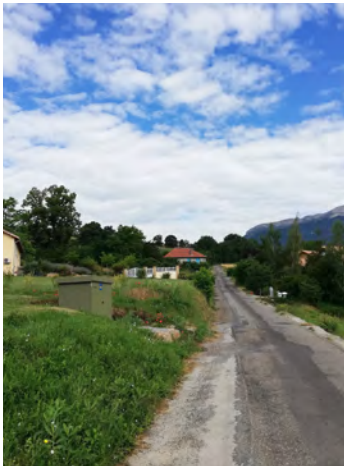
Fouillouse ▪ Enfouissement HTABT ▪ Les Guérins
