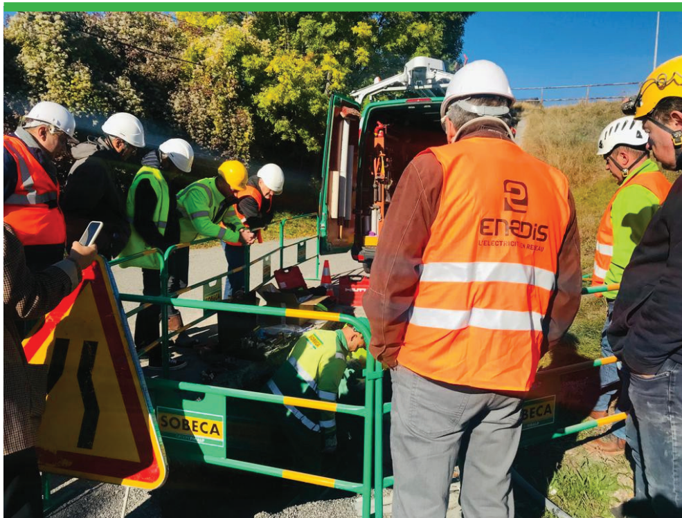
Visite du chantier Enedis par les élus et la presse
