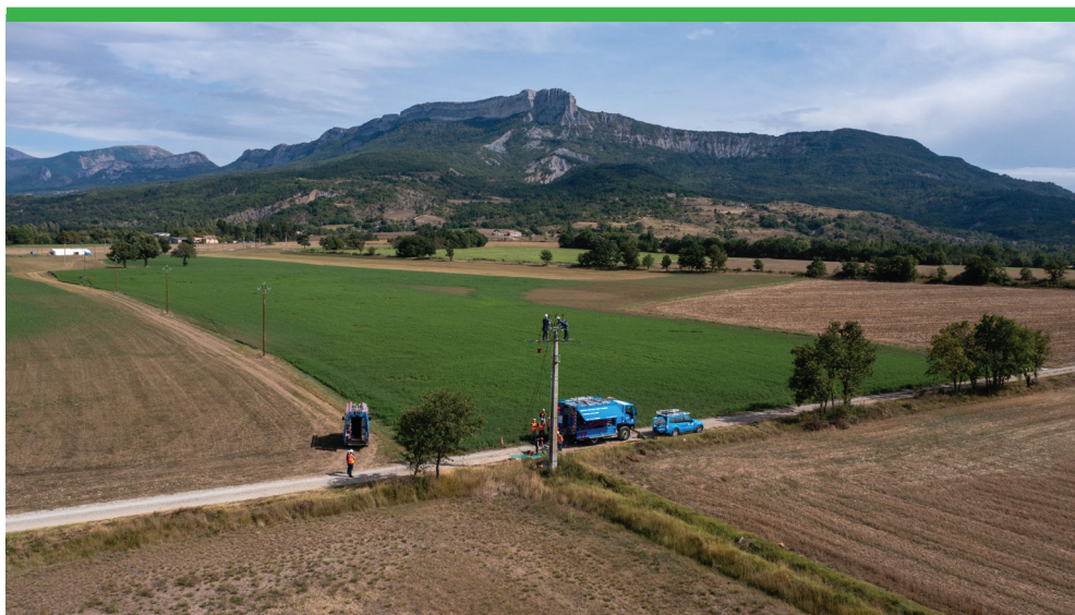
Une partie du chantier conduit par les 140 techniciens Enedis à Valernes.
