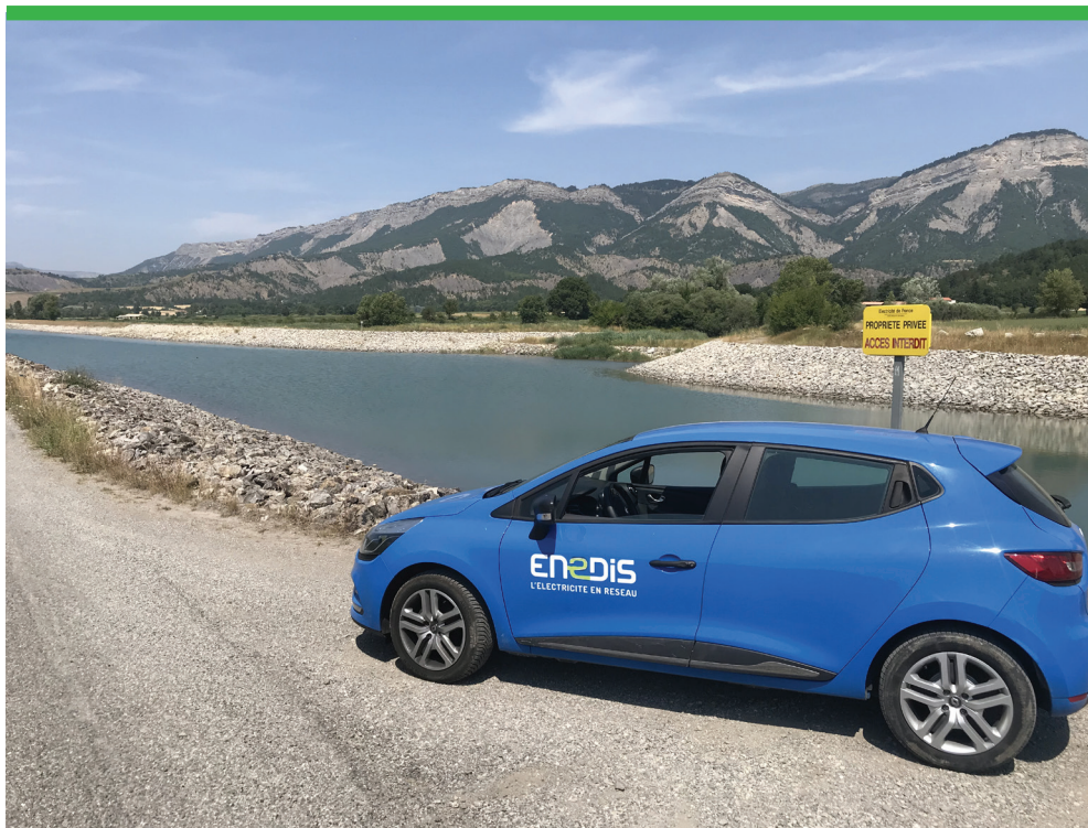
Lors du chantier de raccordement par Enedis de la centrale flottante photovoltaïque à Lazer
