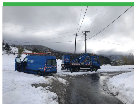
Intervention des équipes Enedis lors des aléas neige
