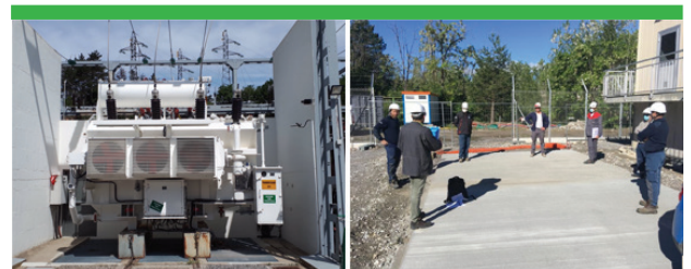
Reprise du chantier en mai 2020 dans le respect des mesures sanitaires
